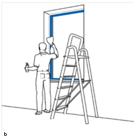
Het oude raamkozijn wordt ontdaan van zijn beslag en deskundig van binnen en buiten gereinigd. Dit produceert nauwelijks geluid of vuil.
