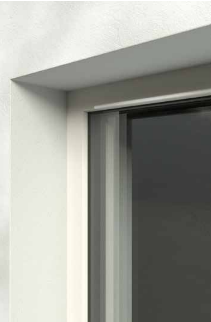
zichtbare montage van het kozijn
