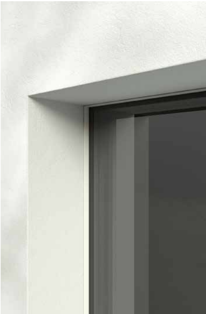
verdektliggende montage van het kozijn
