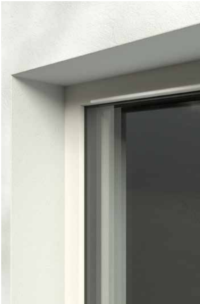
sichtbarer Einbau des Blendrahmens
